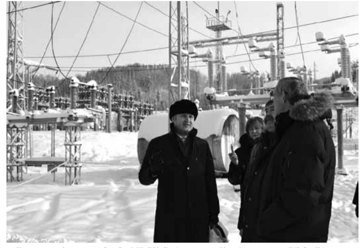
Директор филиала ОАО «МРСК Сибири» — «Кузбассэнерго-РЭС» Евгений Тюменцев докладывает заместителю губернатора Андрею Малахову о проведённой реконструкции подстанции «Кондомская».
